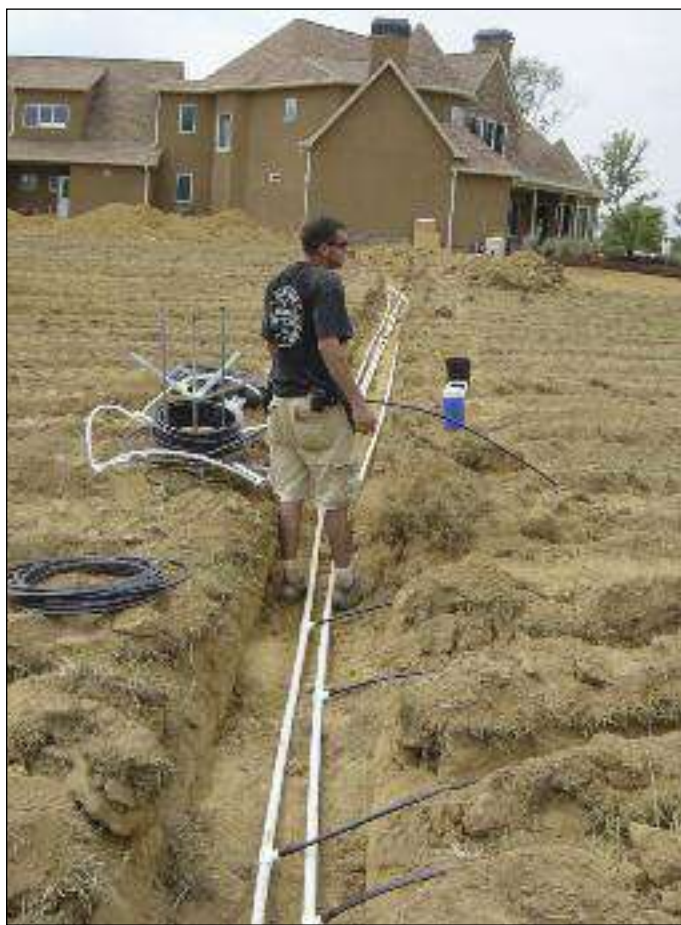
Système de dispersion au goutte-à-goutte
