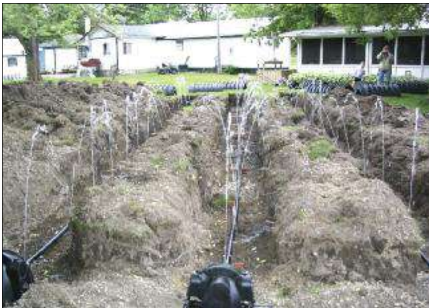
Tranchées enfouies près de la surface ayant des méthodes de distribution égale. Nota : avant le placement des chambres.
