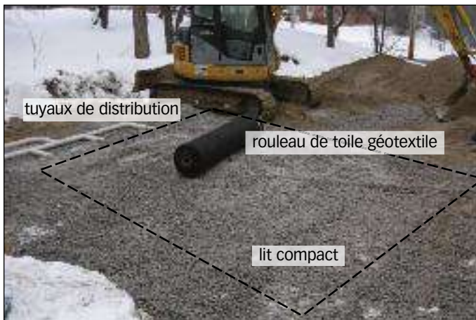
Lit compact montrant la couche de gravier, les tuyaux et la toile géotextile.
