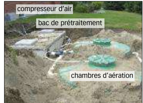
Les systèmes qui traitent un gros volume d'eaux usées peuvent avoir besoin de plus d'une chambre d'aération.
