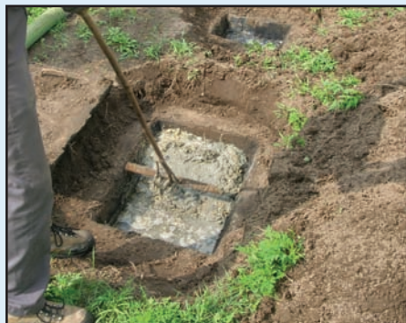
Il y a trop d'écume. Il est temps de pomper votre fosse et d'inspecter votre champ d'épuration
